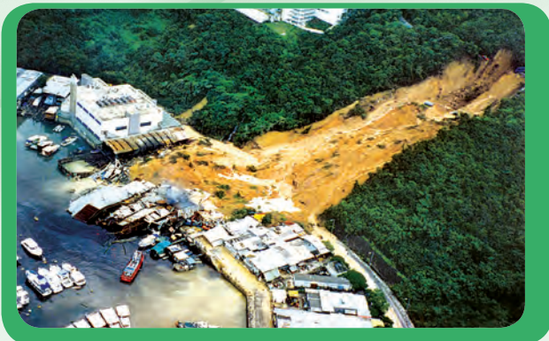
1995年深灣道山泥傾瀉 – 2人死亡 Shum Wan Road Landslide in 1995 – 2 fatalities
