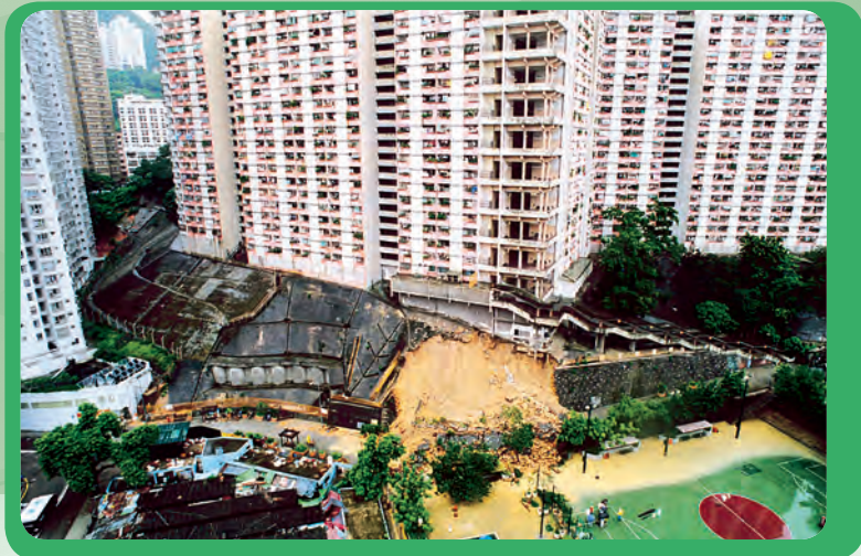
1994年觀龍樓山泥傾瀉 – 5人死亡 Kwun Lung Lau Landslide in 1994 – 5 fatalities
